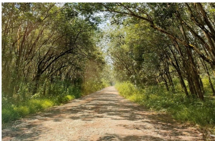
Hình 3.6. Hiện trạng mặt đường vận chuyển sét của các khu mỏ
