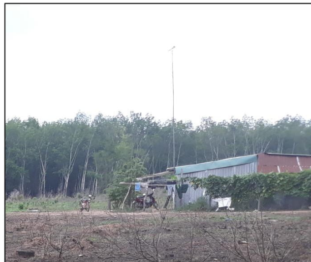
Công trình nhà tạm - phía đông bắc Dự án
