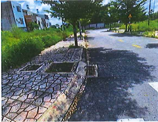
Hình 3. 1. Hệ thống thu gom nước mưa
