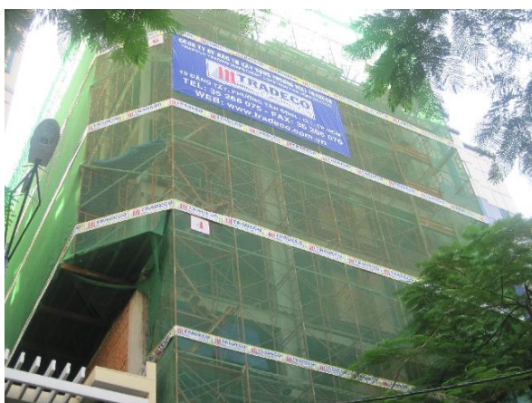
Hình 4. 2. Lưới bao che xung quanh công trình (hình ảnh minh họa)
