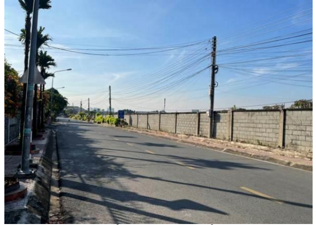
Hiện trạng cấp điện và chiếu sáng dọc đường Liên xã LT-BN-HĐ
