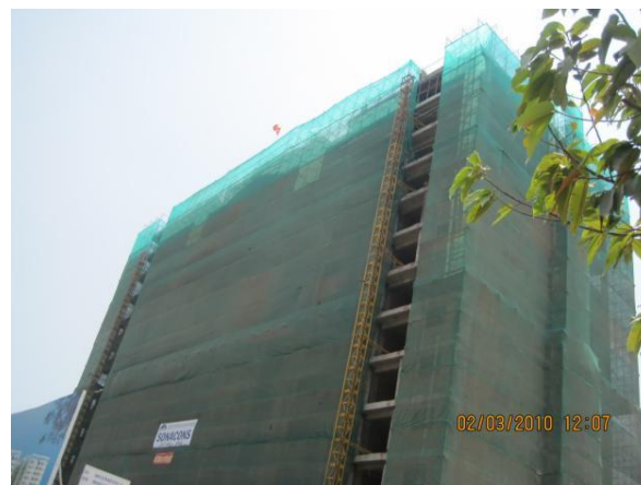
Hình 4. 2. Lưới bao che xung quanh công trình (hình ảnh minh họa)
