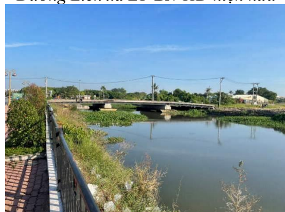
Cầu giáp phía Tây Bắc dự án
