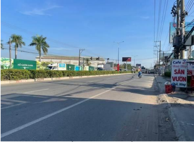
Hiện trạng cấp điện và chiếu sáng dọc đường Đại lộ Bình Dương
