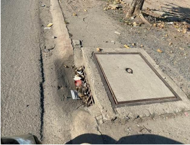
Thoát nước mưa dọc Đại lộ Bình Dương
