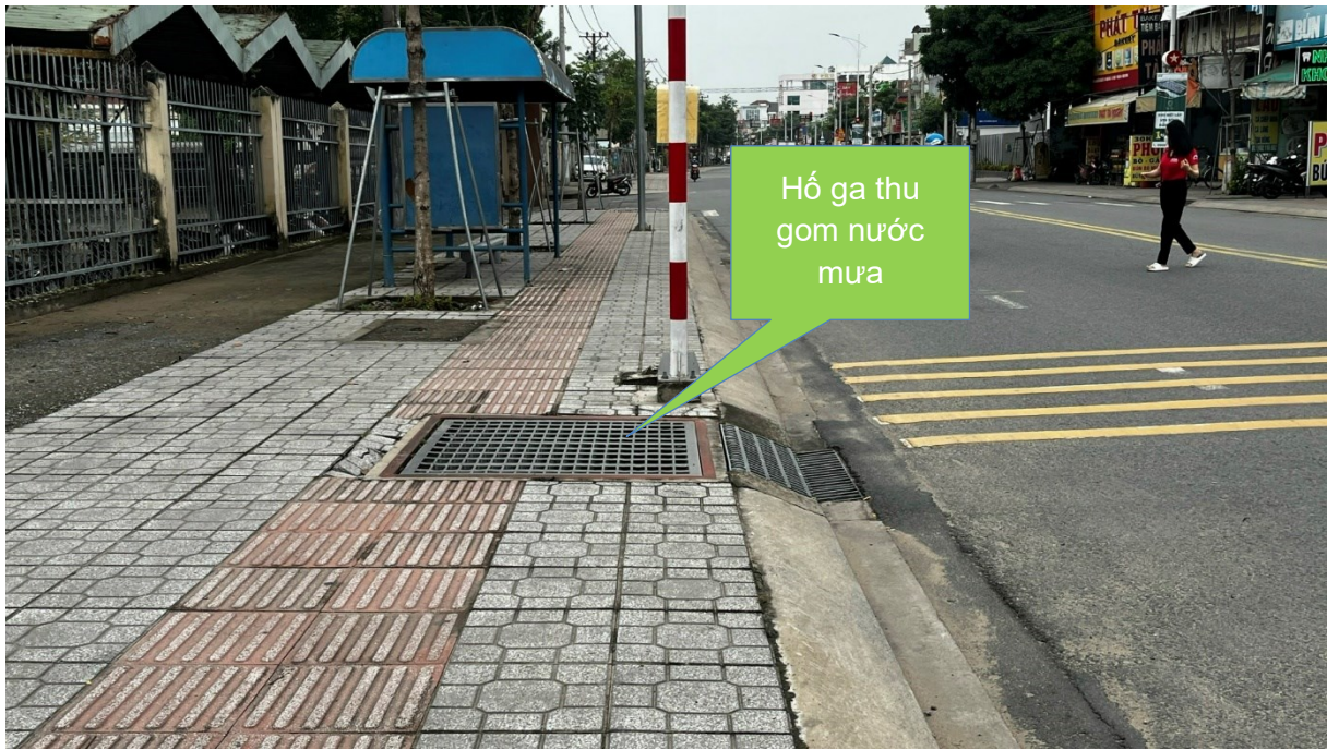
Hình 1. 7. Tuyến cống thu gom nước mưa trên đường Nguyễn Văn Tiết
