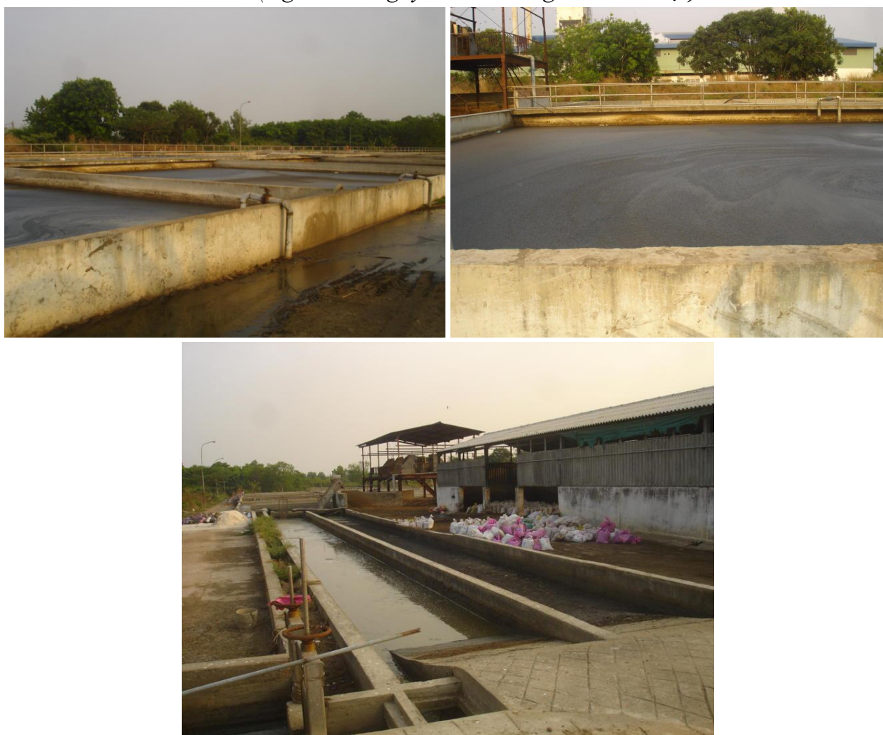
Hình 3. 3. Hình ảnh hệ thống xử lý nước thải
