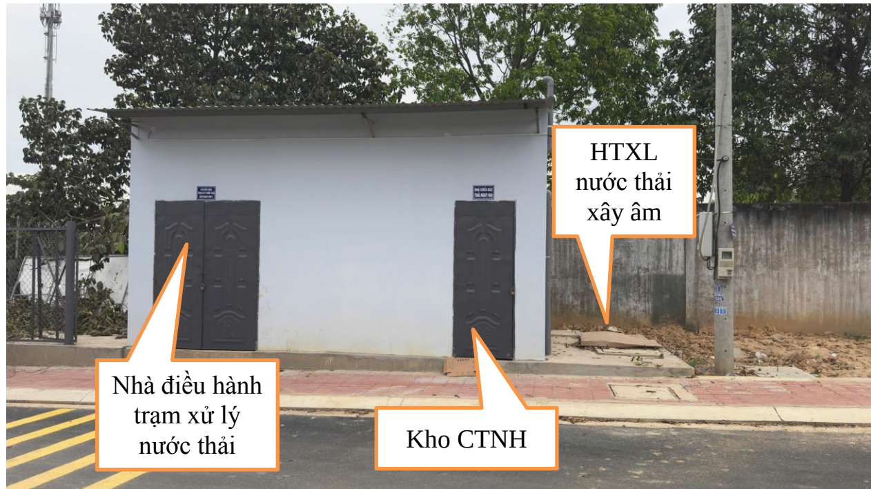
Hình 3. 4. Hình ảnh HTXL nước thải của Công ty
