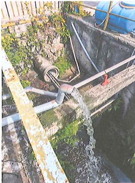
Hình 3. 3. Hình ảnh ống xả nước thải của Khu sản xuất.
