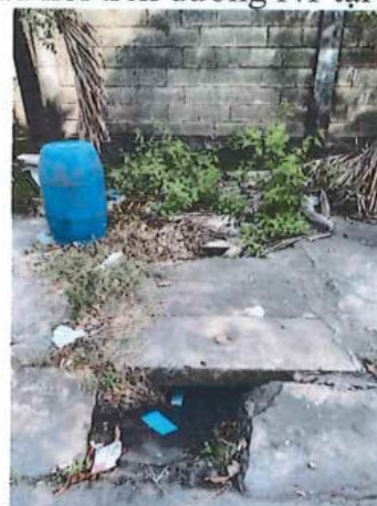
Hồ ga đầu nổi trên đường N1 tại vị trí số 3
