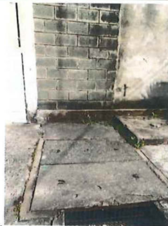
Hồ ga đầu nổi trên đường N1 tại vị trí số 2
