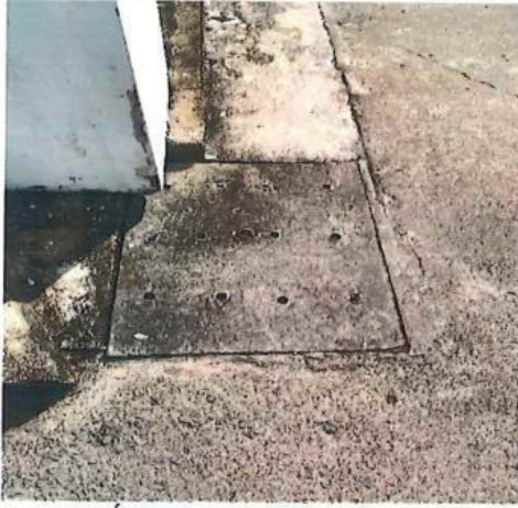
Hồ ga nước mưa nội bộ
