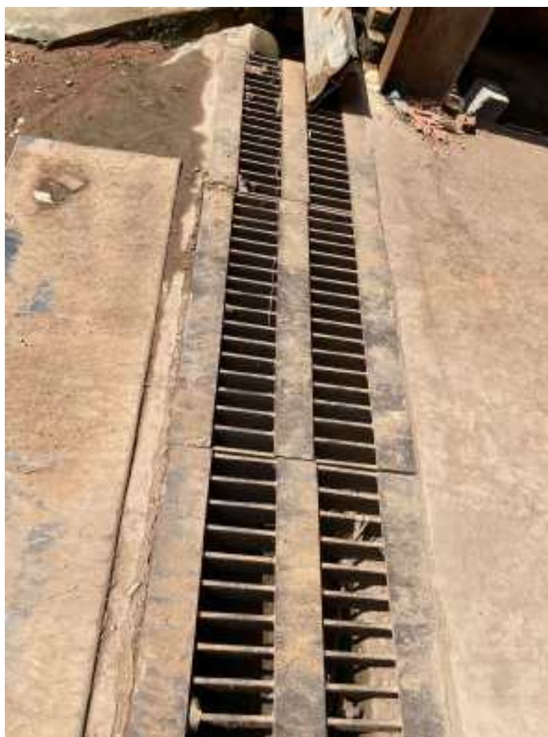
Hình 3. 1 Hệ thống thu gom nước mưa
