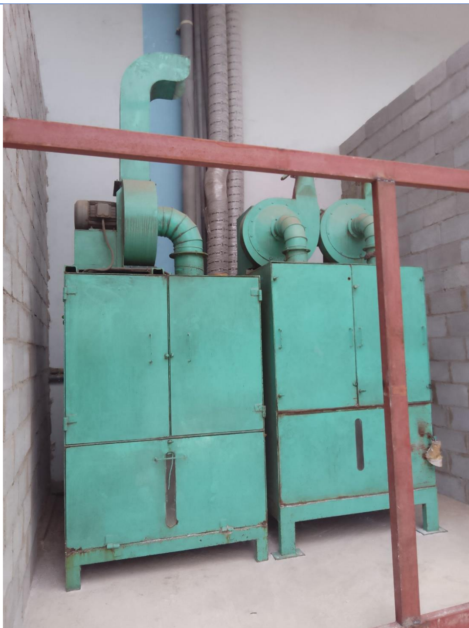
Hình 30. Hệ thống lọc bụi từ công đoạn mài miếng lót giày tại nhà máy
