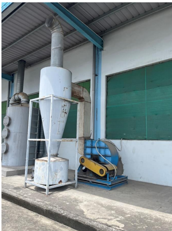
Hình 20. Hệ thống Cyclone thu gom bụi từ công đoạn mài để giày
