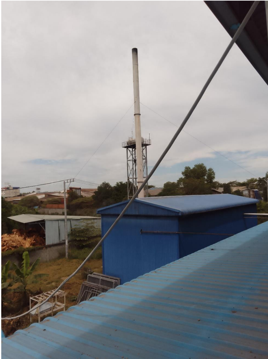
Hình 29. Ống thải hệ thống xử lý khí thải lò hơi đốt viên nén mùn cưa
