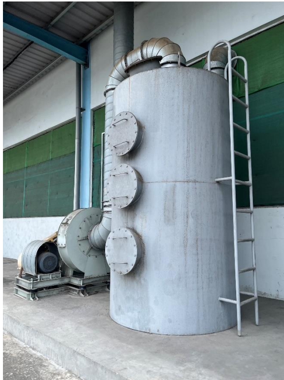
Hình 18. Hệ thống xử lý hơi dung môi phát sinh từ quá trình dán keo và sơn dặm
