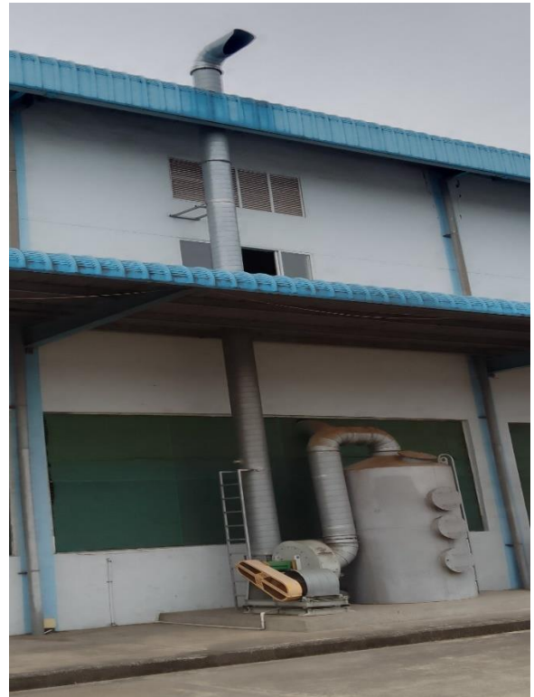
Hình 18. Hệ thống xử lý hơi dung môi phát sinh từ quá trình dán keo và sơn dặm
