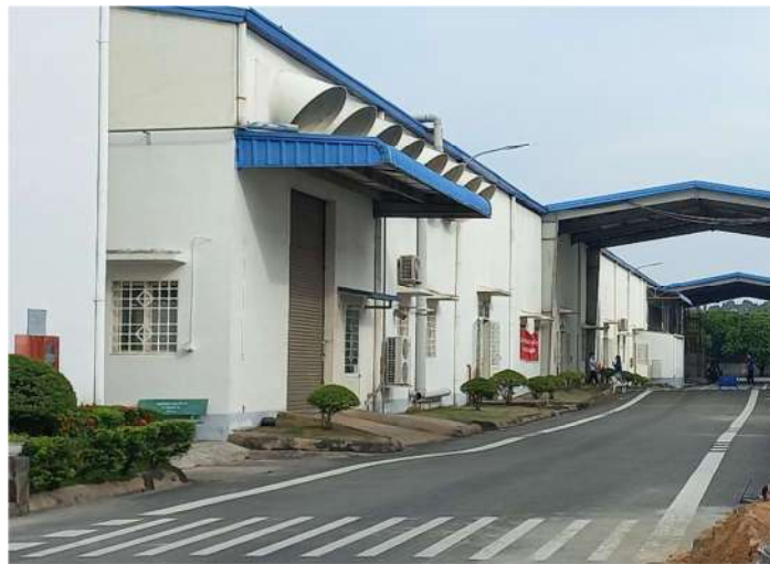
Hình 1. 19. Nhà xưởng B hiện hữu
