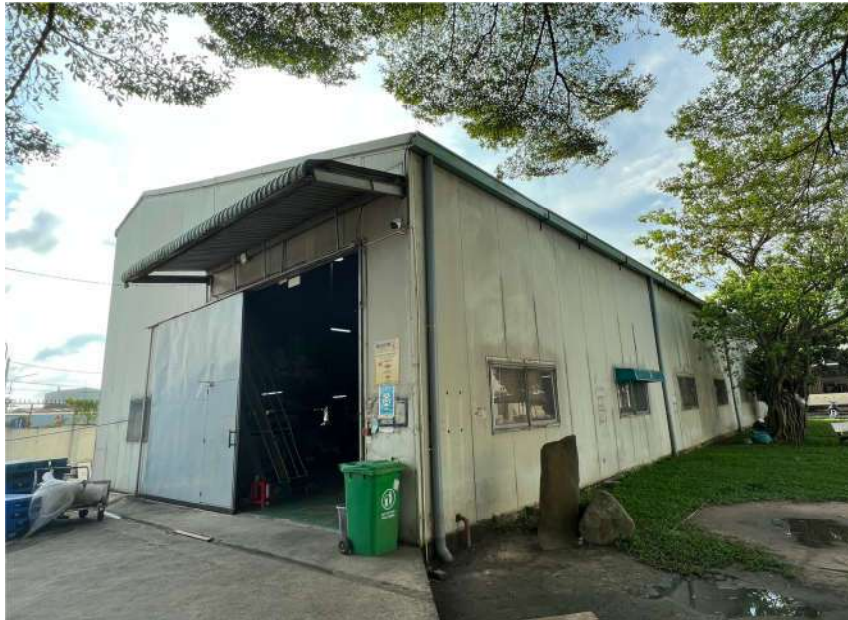
Hình 1. 20. Nhà xưởng C hiện hữu
