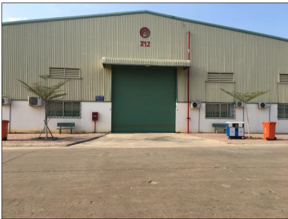
Hình 1.3. Bên ngoài nhà xưởng
