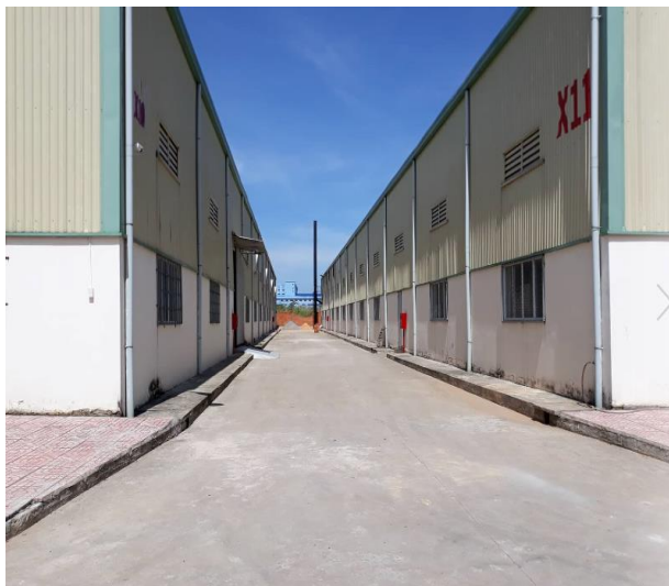
Hình 3.11. Mặt đường đã bê tông hóa
