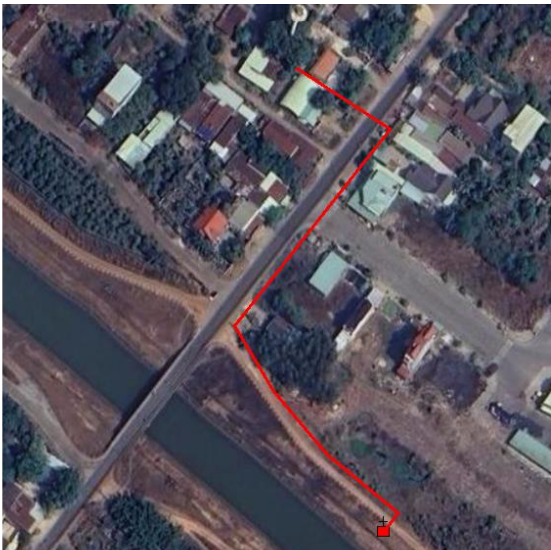
Hình 1. 4. Tuyến ống dẫn nước thô từ kênh PH-DT về trạm cấp nước xã Minh Tân
