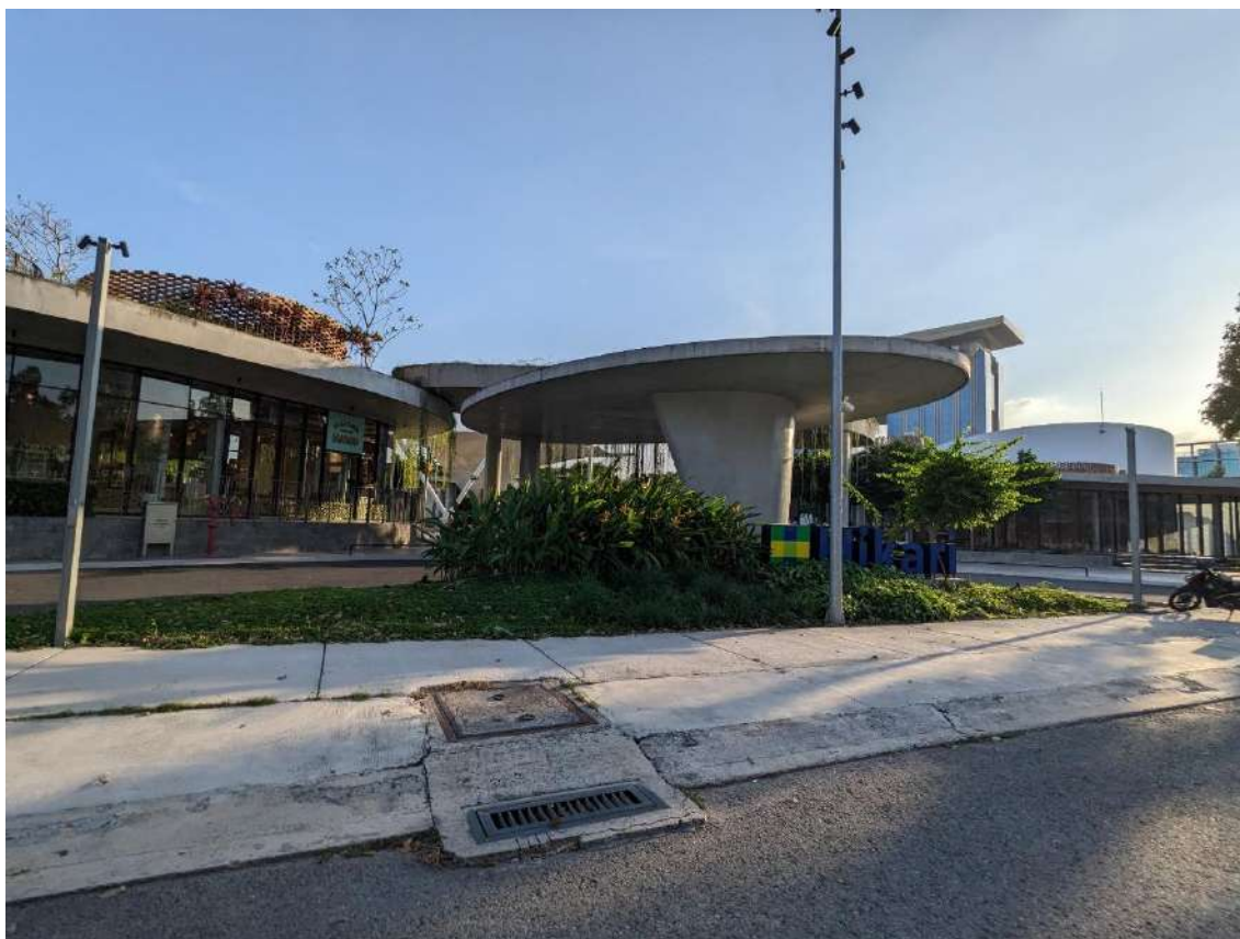
Hình 1. 7: Hồ ga nước mưa của khu vực Lô A11
