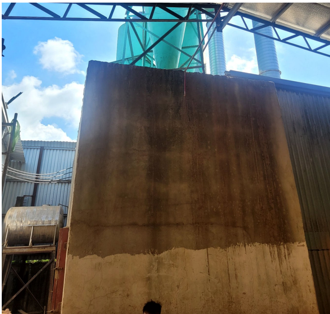
Hình 15 Hệ thống xử lý bụi thải số 2
