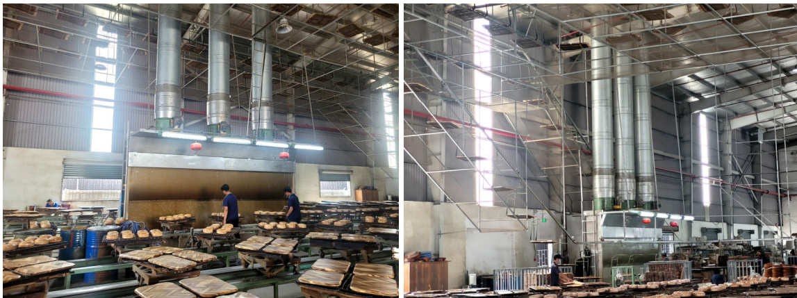
Hình 18 Hệ thống xử lý hơi dung môi bằng công nghệ màng phun nước hấp thụ
