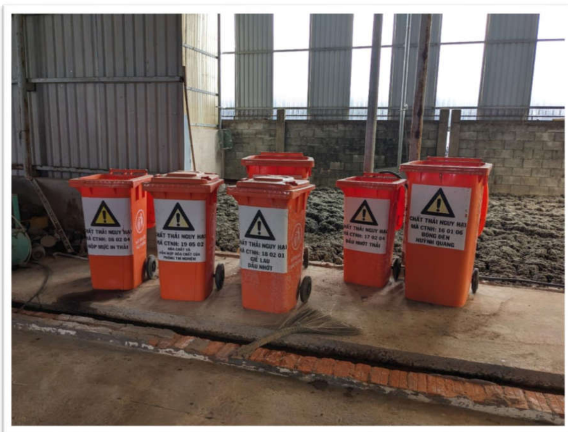
Hình 3. 10. Kho chứa chất thải nguy hại tại Nhà máy XLNT tập trung của Cụm công nghiệp Uyên Hưng.
