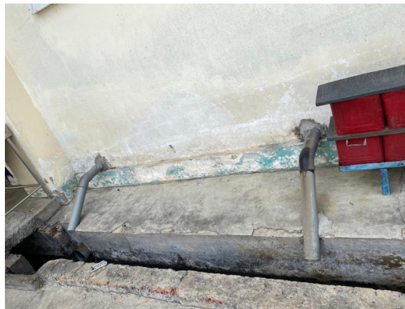
Hệ thống thu gom nước thải từ nhà ăn
