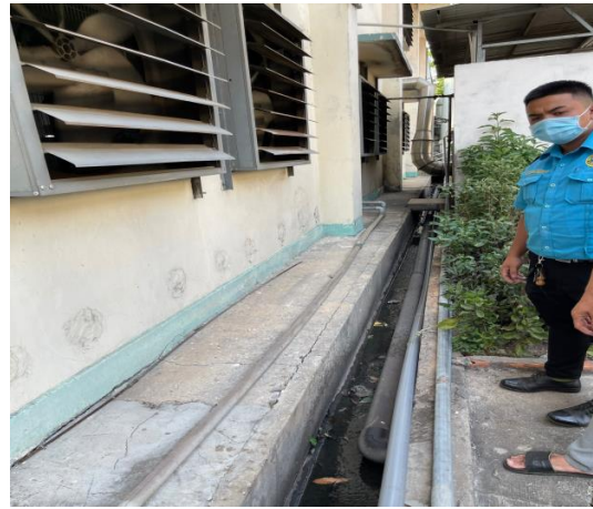
Hệ thống thu gom nước thải sản xuất từ quá trình rửa đế giày
