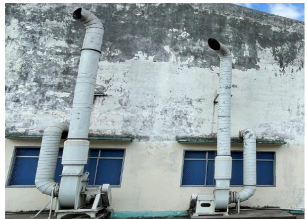
Hình 3. 19. Hệ thống xử lý hơi dung môi của Công ty
