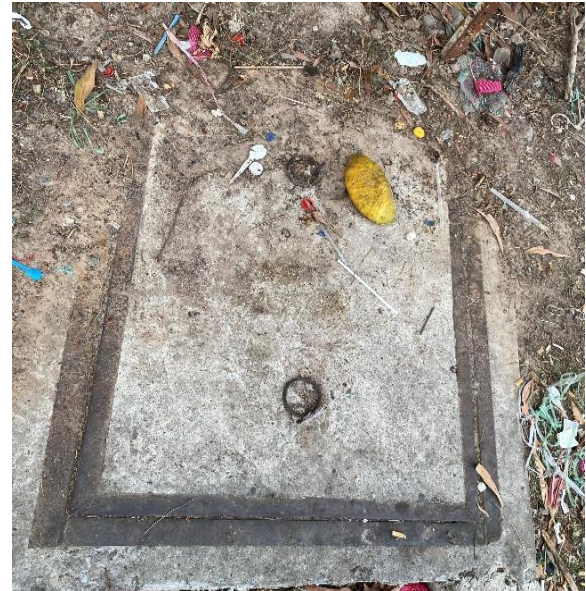
Hố ga đầu nối nước mưa
