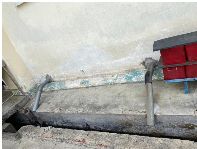
Hệ thống thu gom nước thải từ nhà ăn
