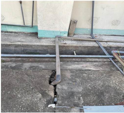
Hệ thống thu gom nước thải sản xuất từ quá trình rửa đế giày
