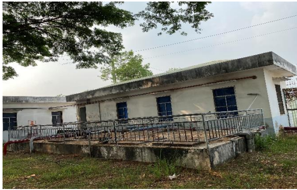
Bể nước PCCC
