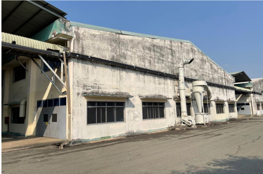
Hình 3. 15. Hệ thống xử lý bụi tại công đoạn mài nhám của Công ty
