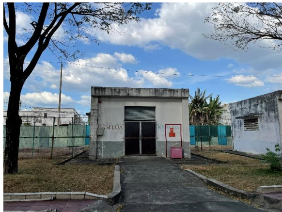
Kho gas phục vụ nấu ăn
