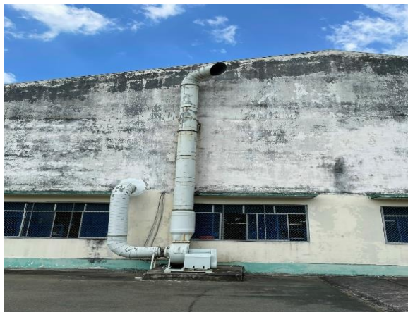
Hình 3. 19. Hệ thống xử lý hơi dung môi của Công ty
