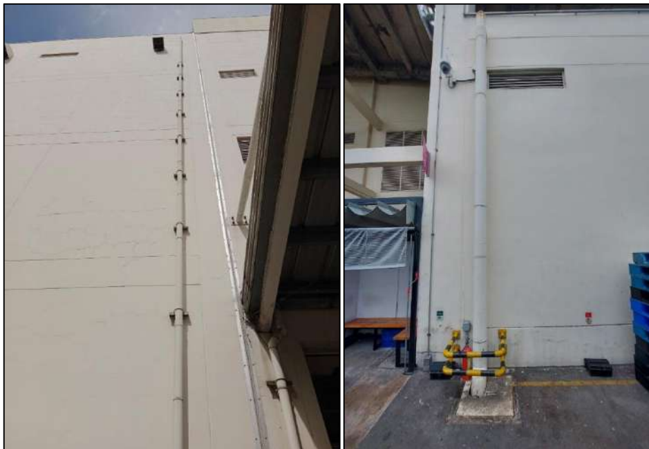
Hình III.1. Vị trí ống đứng thoát nước mưa.
