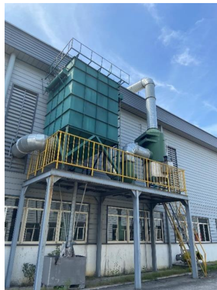
HTXLKT công đoạn nối đầu ruột xe
