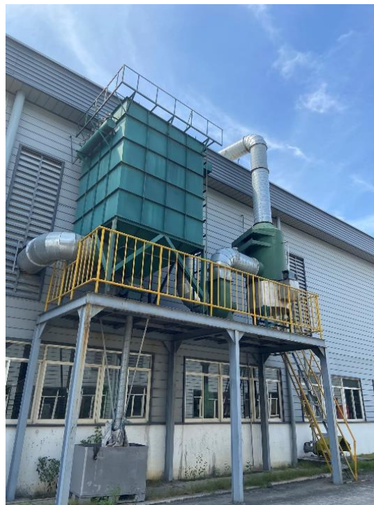
Hình 3. 11. Cấu tạo HTXL khí thải từ công đoạn nối đầu ruột xe
