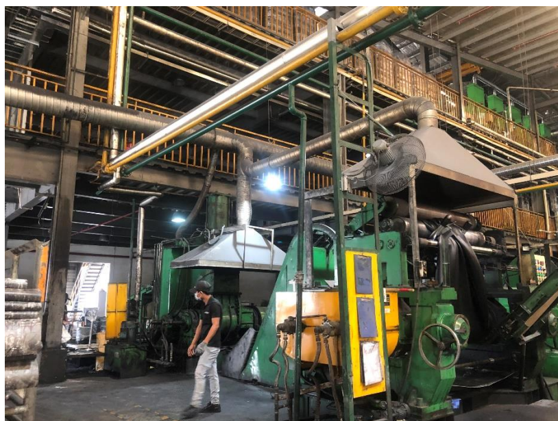
Hình 3. 7. Cấu tạo HTXL bụi tại công đoạn nạp liệu, trộn, luyên
