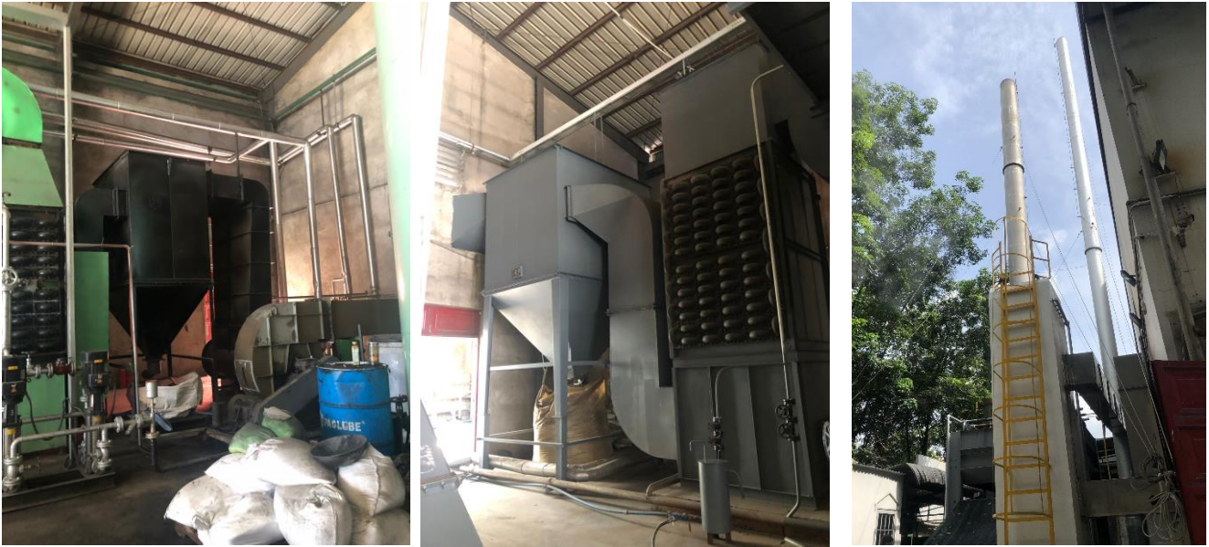
Hình 1. 21. HTXLKT lò hơi Biomass 6 tấn và 15 tấn
