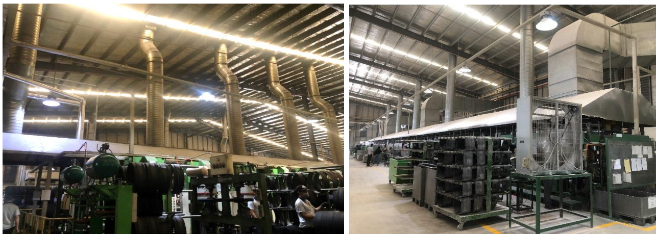
Hình 3. 15. Hệ thống xử lý mùi và hơi hóa chất từ quá trình lưu hóa lốp xe và ruột xe
