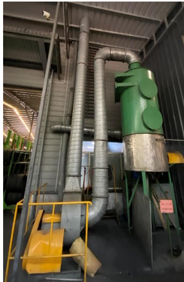
Bảng 3. 10. Cấu tạo HTXL khí thải từ quá trình phun chất chống dính lốp xe
