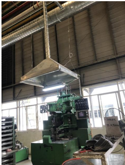
Hình 3. 10. Hệ thống chụp hút, ống thu gom khí thải từ công đoạn nối đầu ruột xe
