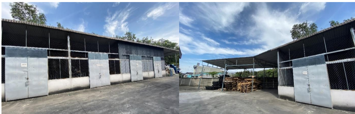
Hình 3. 20. Kho chứa chất thải công nghiệp thông thường
