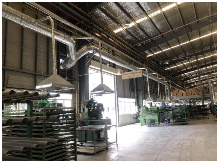
Hình 3. 10. Hệ thống chụp hút, ống thu gom khí thải từ công đoạn nối đầu ruột xe
