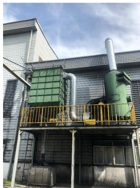
Hình 3. 7. Cấu tạo HTXL bụi tại công đoạn nạp liệu, trộn, luyên
