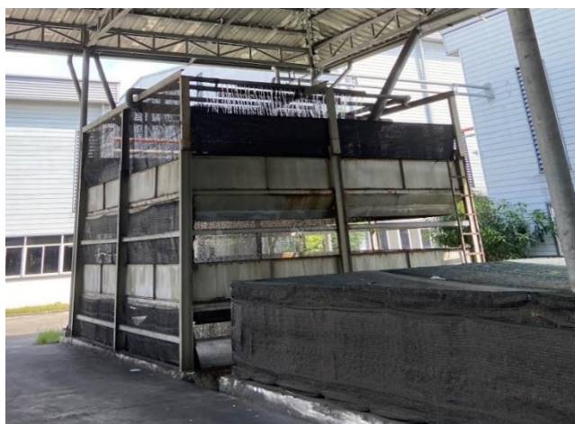
Hình 1. 15. HTXLNT nước làm mát
