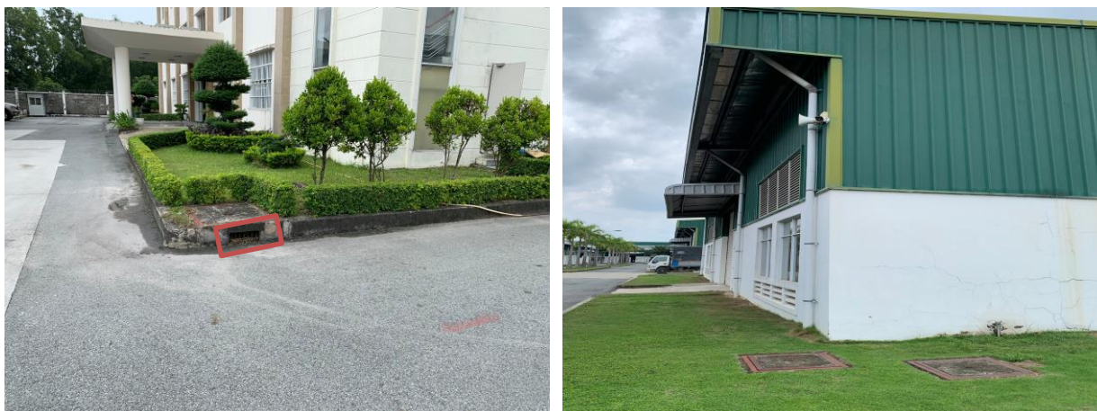
Hình 3. 2. Ống thu gom nước mưa trên mái và hố ga dưới mặt đất
