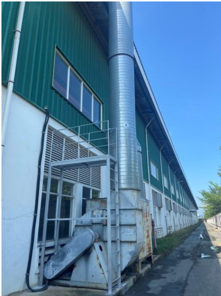
Hình 3. 8. Hình ảnh HTXL khí thải tại cơ sở
