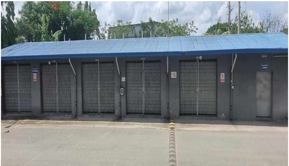
Hình 3. 5 Hình ảnh nhà máy phát điện tại Dự án
