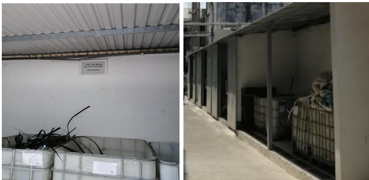
Hình III.9: Hình ảnh thực tế của kho chứa chất thải công nghiệp thông thường của cơ sở.
