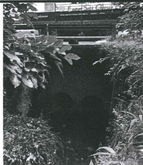
CỐNG THOÁT NƯỚC SUỐI
