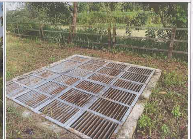
Hố thu nước mưa xả ra kênh K1
