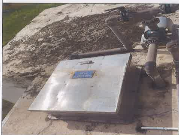
Bể chứa bùn
