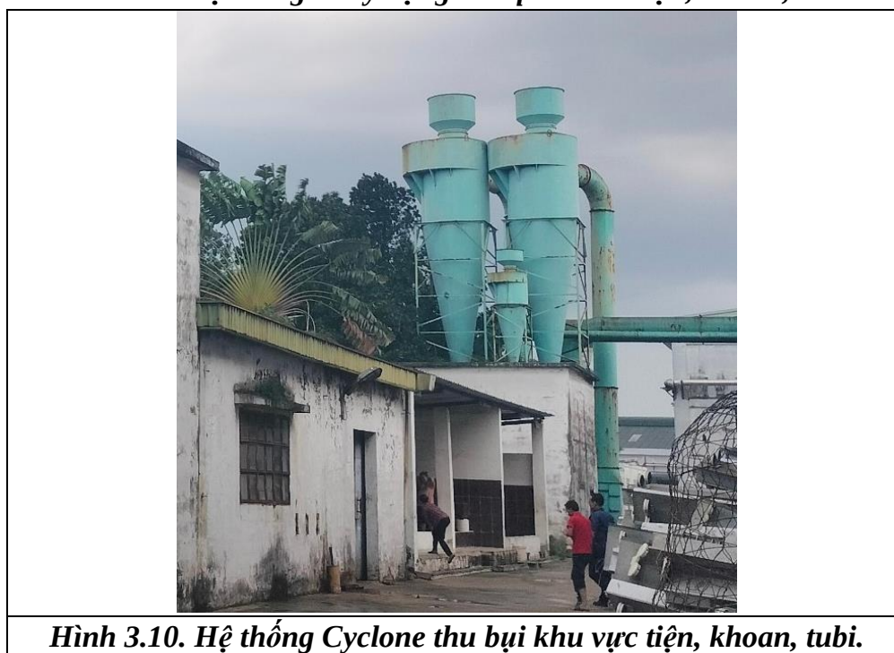
Hình 3.9. Hệ thống xử lý bụi gỗ từ quá trình tiện, khoan, tubi.
