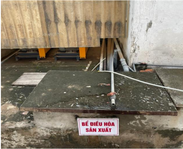
Bể điều hòa nước thải sản xuất.
