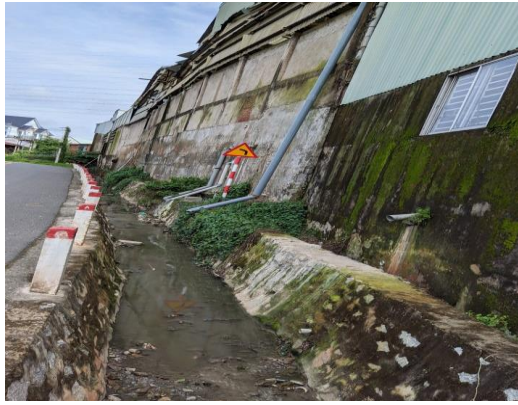
Hình 2. 1. Mương thoát nước của khu vực
