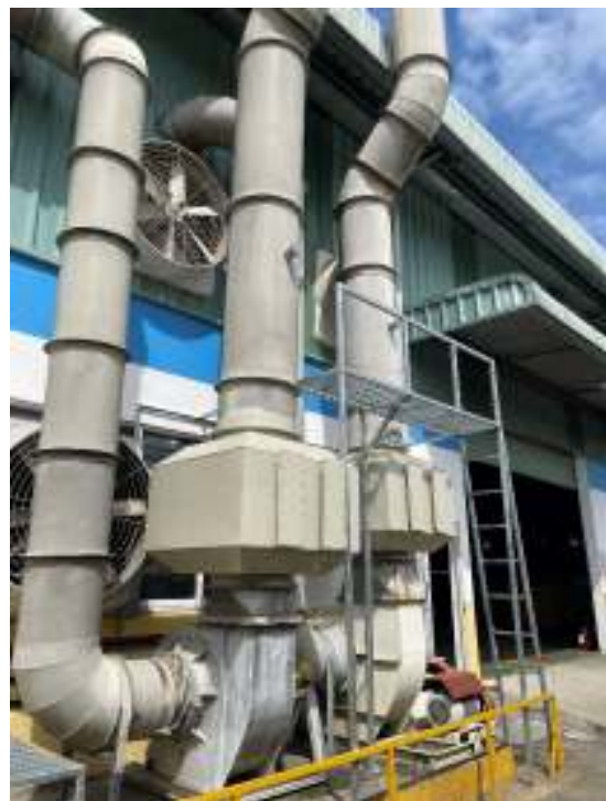
Hệ thống xử lý khí thải hơi dung môi từ quá trình quét keo – gia công giày thành phẩm (Nhà máy 2)
