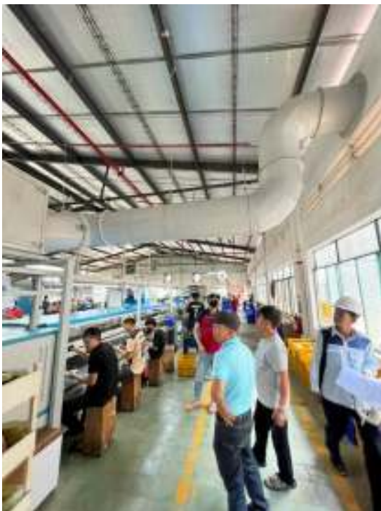
Hệ thống xử lý khí thải hơi dung môi từ quá trình quét keo – gia công giày thành phẩm (Nhà máy 2)
