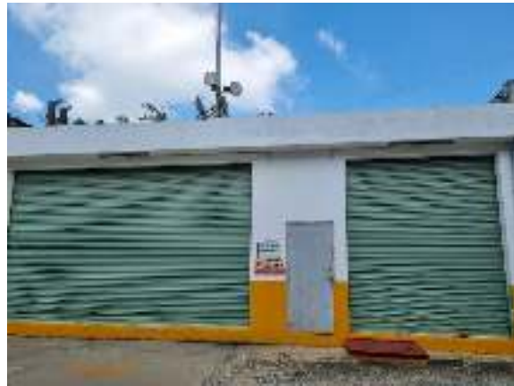
Nhà máy phát điện tại Nhà máy 2
