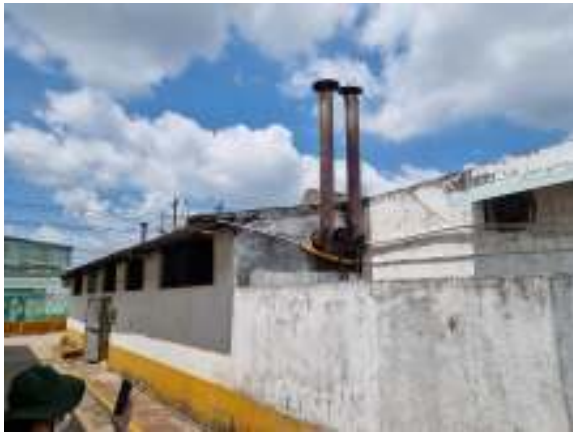
Nhà máy phát điện tại Nhà máy 1
