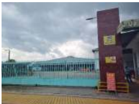
Cổng chính của Nhà máy 2
