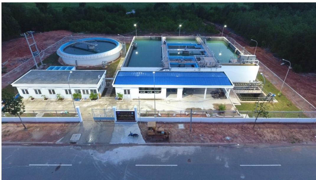
Hình 2. 2: Hình ảnh về trạm xử lý nước thải 4.000m 3 /ngày.đêm của KCN Thới Hòa
