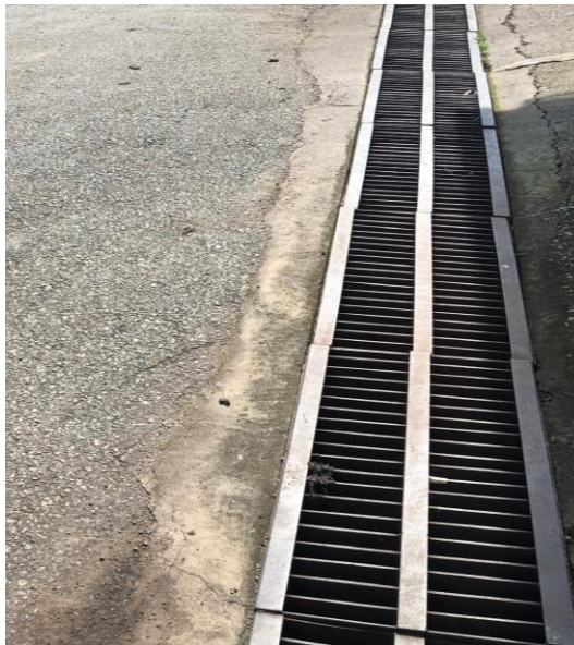
Hình 3. 2: Đường mương thoát nước mưa giữa các nhà xưởng
