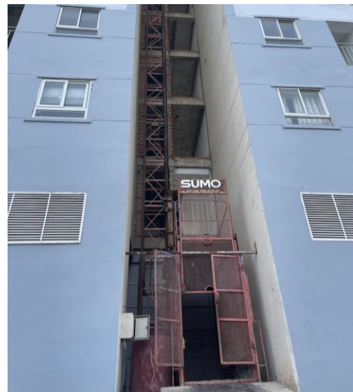
Hình 1.4. Thang máy vận chuyển rác thải từ các tầng
