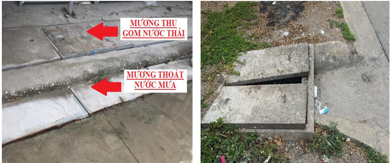
Hình 3. 3. Mương và hố ga đầu nối thoát nước mưa
