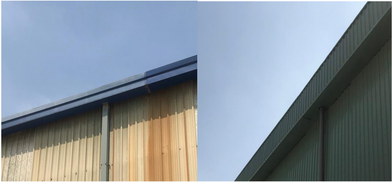
Hình 3. 2. Kiểu ống thoát nước mưa trên mái
