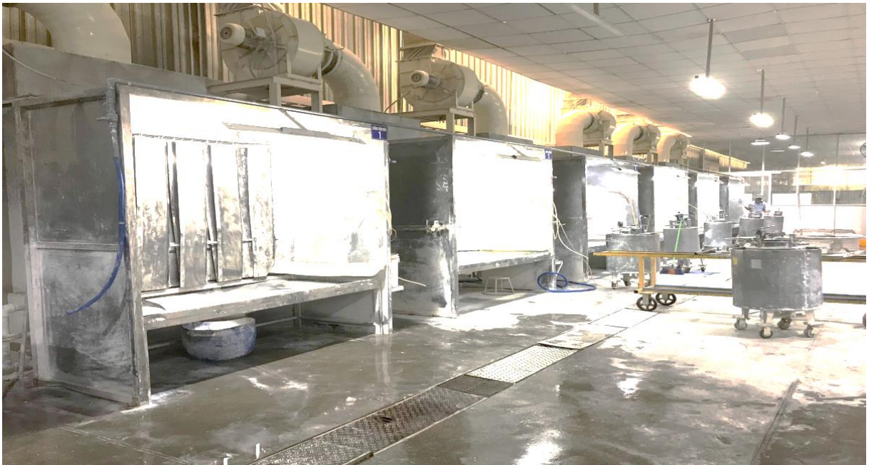
Hình 3. 17. Khu vực phun men tại dự án
