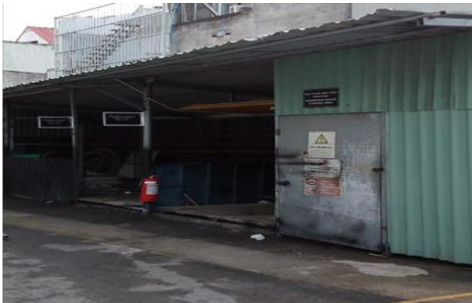
Hình 3. 14. Kho lưu chứa chất thải rắn công nghiệp thông thường tại Công ty
