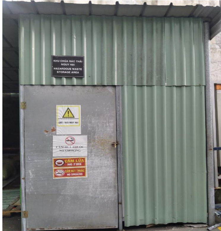
Hình 3. 16. Kho lưu trữ chất thải nguy hại tại Công ty
