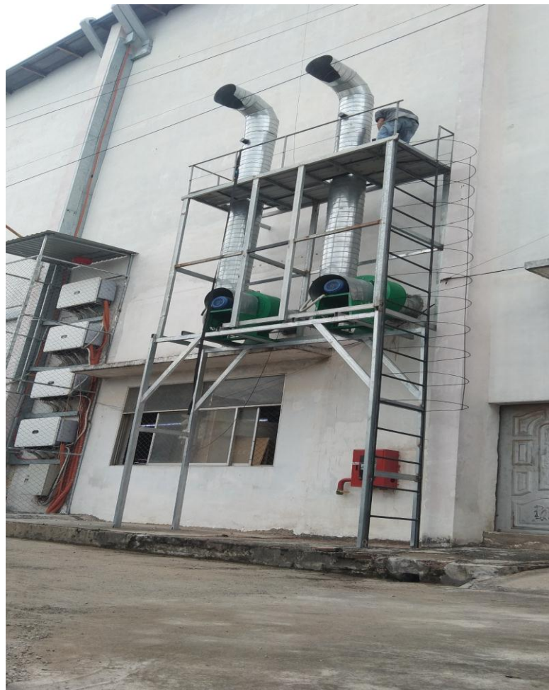
Hình 3.13. Ống thoát khí thải sau xử lý tại khu vực dán keo
