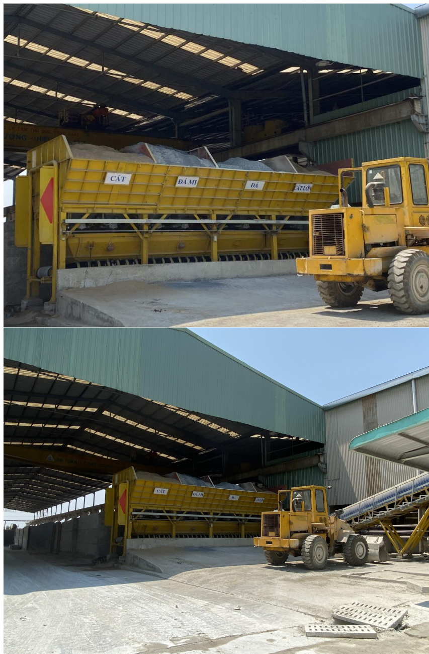
Hình 3.5. Hình ảnh thực tế dây chuyền tải nguyên liệu tại Nhà máy
