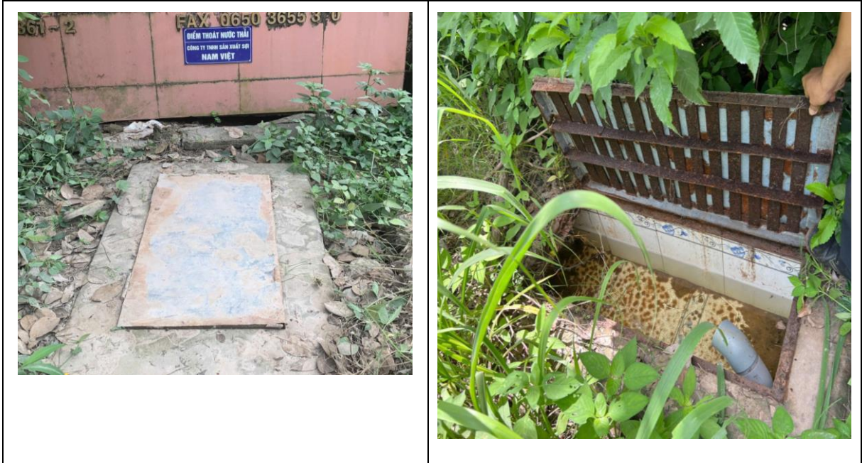
Hình 3. 4. Hồ ga đầu nối nước thải sau xử lý của Nhà máy
