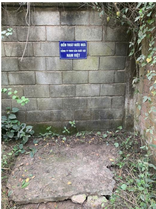
Hố ga đầu nối nước mưa có gắn biển báo theo quy định
