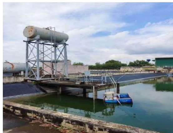
Hình 1. 4. Hồ chứa nước mưa và hệ thống lắng lọc nước mưa trước khi đưa vào sử dụng
