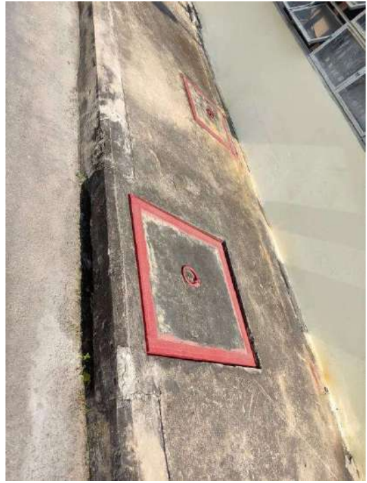
Hố ga thoát nước mưa
