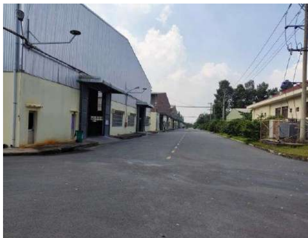
Nhà xưởng sản xuất
