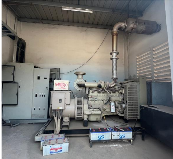
Hình 3. 14. Ống khói máy phát điện tại cơ sở
