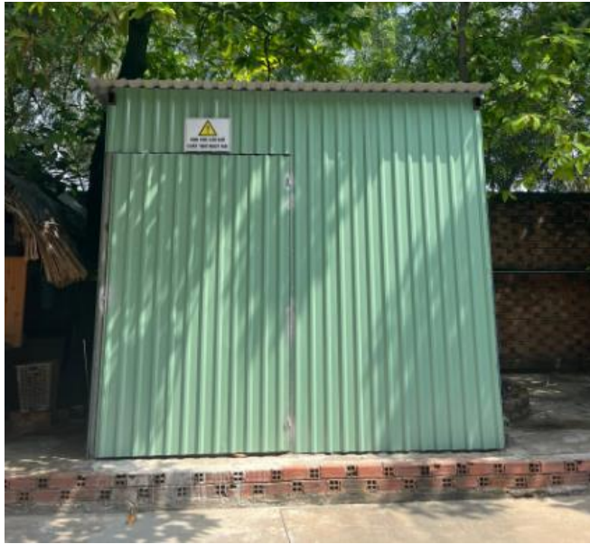
Hình 3. 13. Kho chất thải nguy hại tại cơ sở
