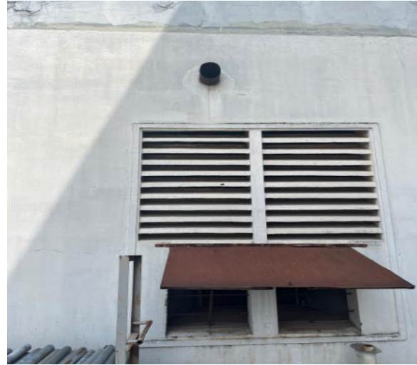
Hình 3. 14. Ống khói máy phát điện tại cơ sở
