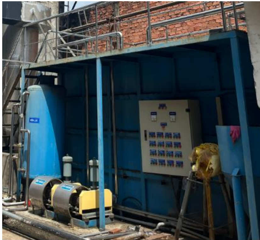
Hình 1. 7. Khu vực HTXL nước thải 15 m 3 /ngày.đêm của cơ sở
