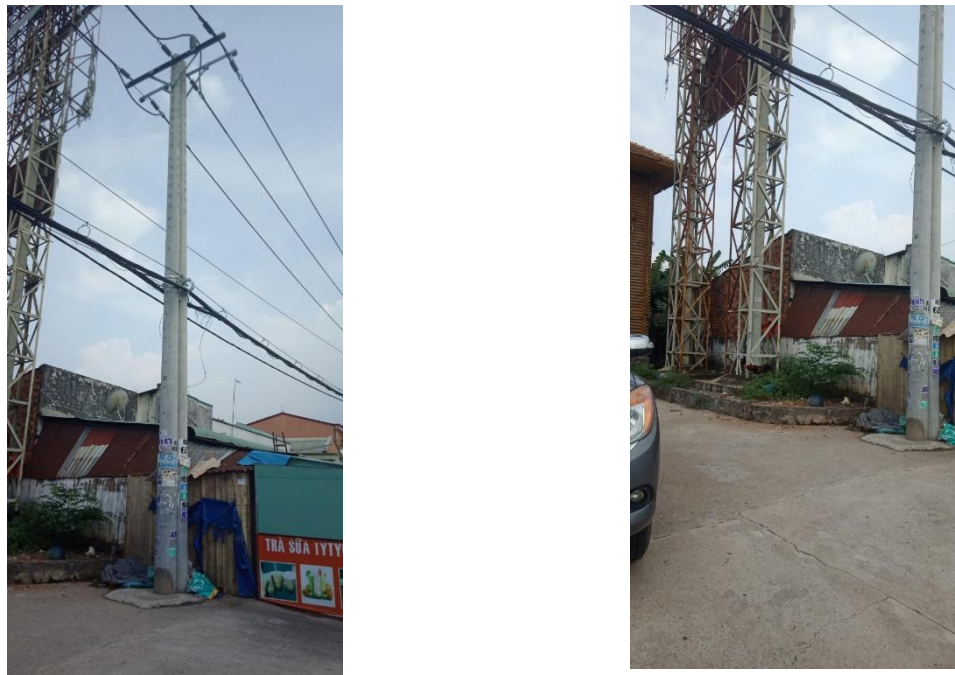
Hình 1. 6. Hiện trạng hạ tầng kỹ thuật
