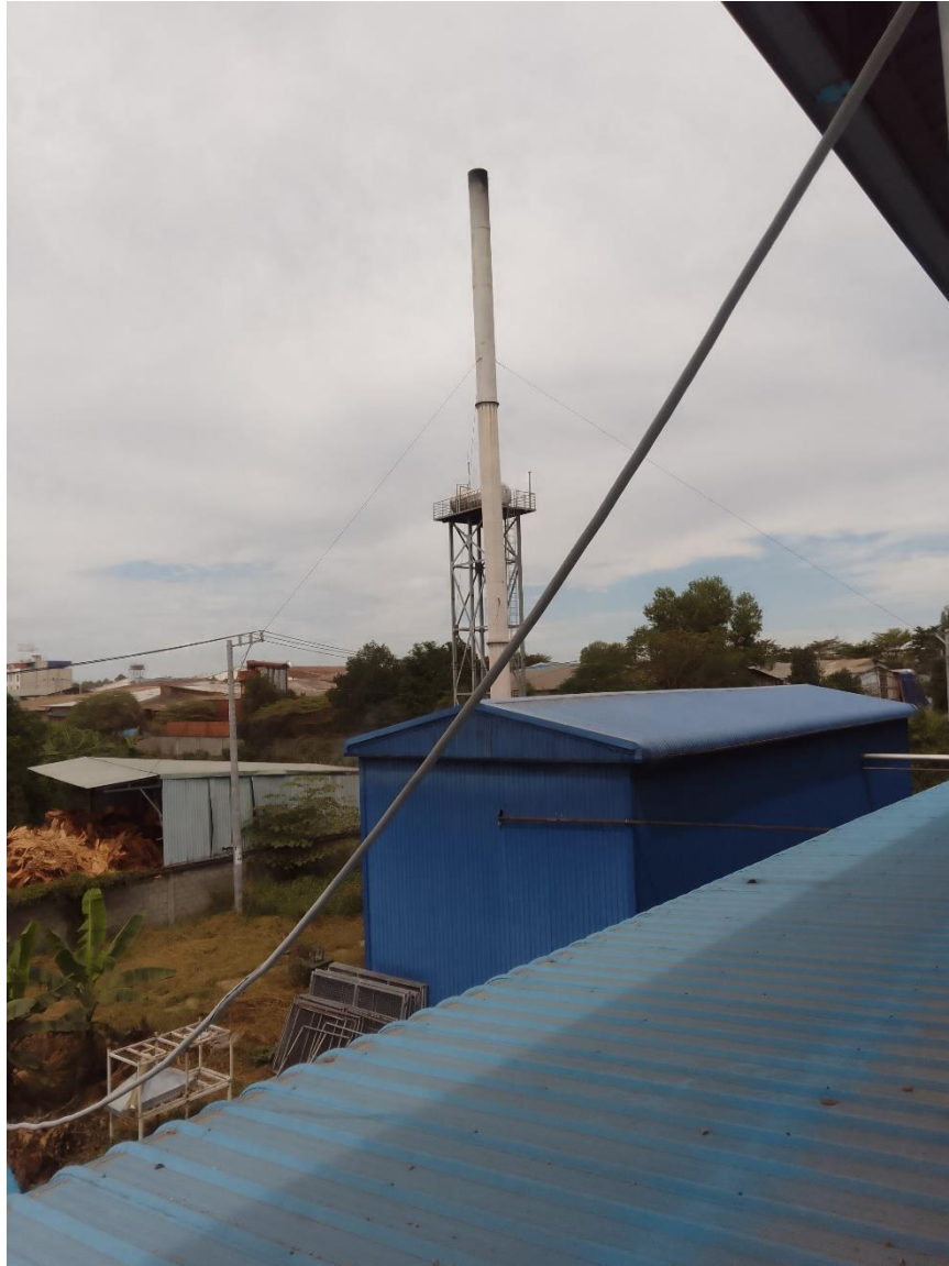
Hình 3.20. Ống thải hệ thống xử lý khí thải lò hơi đốt viên nén mùn cưa
