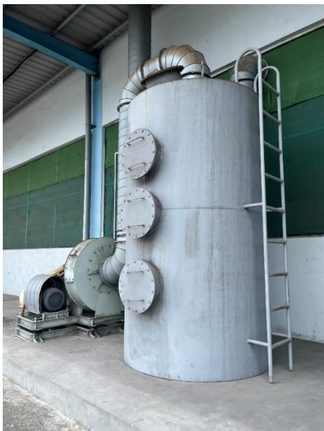
Hình 3.9. Hệ thống xử lý hơi dung môi phát sinh từ quá trình dán keo và sơn dặm
