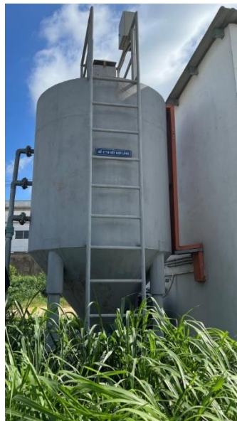
Hình 3.7. Một số hình ảnh tại hệ thống xử lý nước thải tập trung của Nhà máy Thuyết minh quy trình xử lý nước thải sản xuất:
