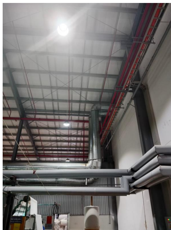
Đường ống thu gom khí thải, nhiệt dư từ hệ thống buồng nhiệt sấy khô 2, 3
