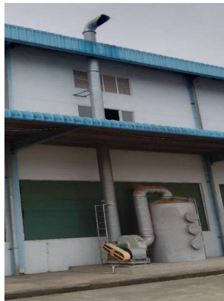
Hình 3.9. Hệ thống xử lý hơi dung môi phát sinh từ quá trình dán keo và sơn dặm
