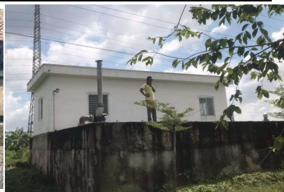
Hệ thống xử lý nước thải: 750 m 3 /ngày
