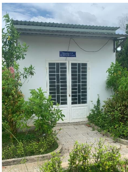
Hình 3. 4. Hệ thống xử lý nước thải của dự án đã được xây dựng hoàn chỉnh
