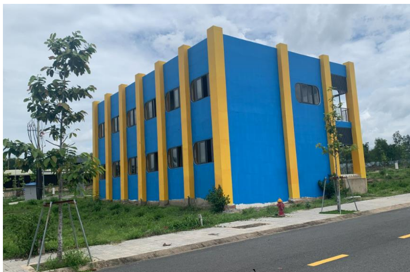
Hình 1. 3. Công trình nhóm trẻ (trường mầm non) đã được xây dựng hoàn chỉnh
