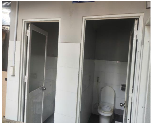
Nhà vệ sinh kho cho thuê (số 3)
