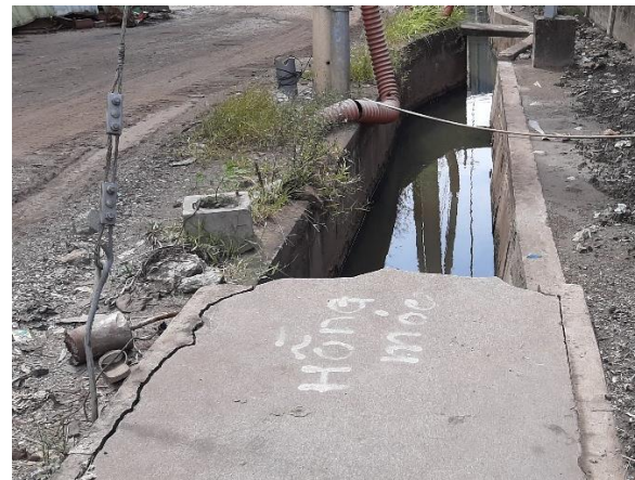
Mương thoát nước khu phố Tân Thắng phía Tây cơ sở
