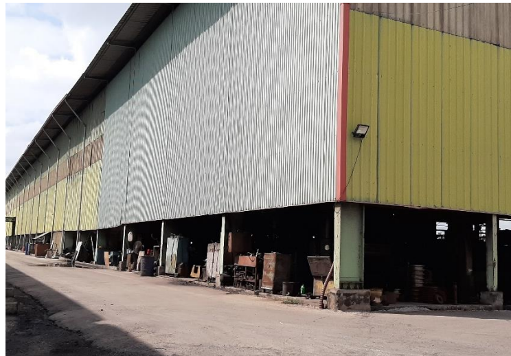
Hình 3. 3: Máng xối và đường ống thu gom nước mưa từ mái nhà xưởng
