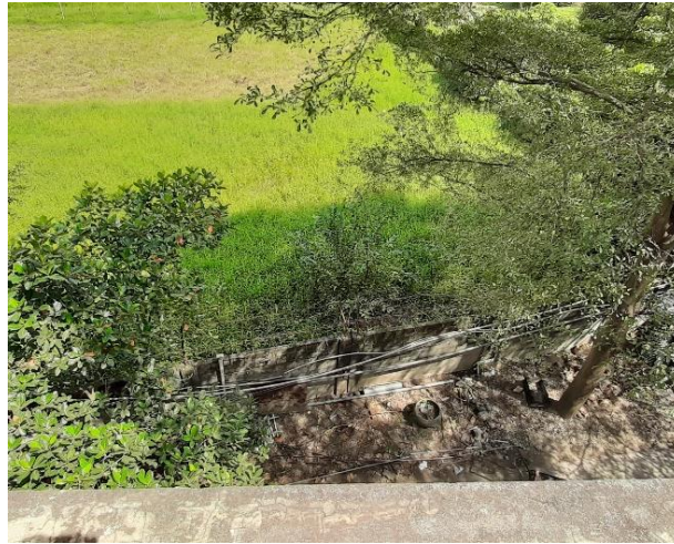
Mương thoát nước khu phố Tân Thắng phía Bắc cơ sở
