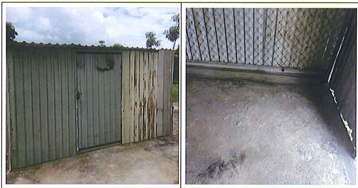
Hình 3-11: Nhà chứa chất thải nguy hại của dự án
