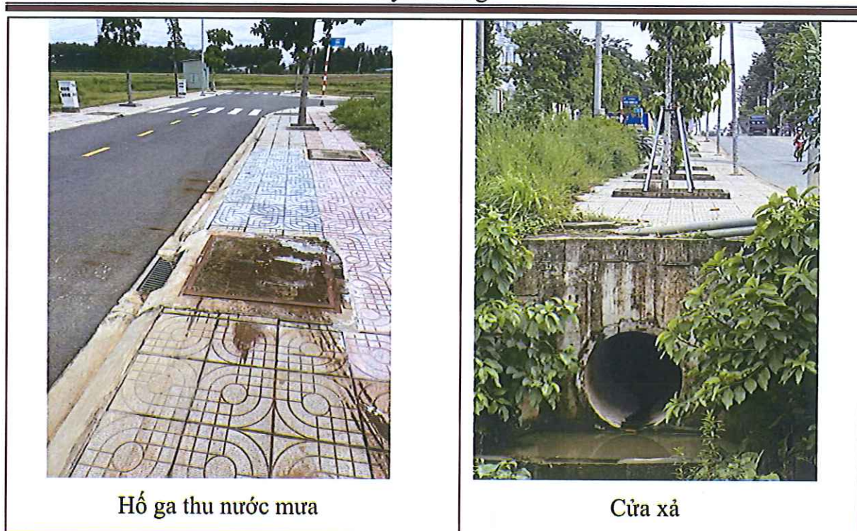
Hình 3-2: Tuyến thoát nước mưa và cửa xả đã thi công tại dự án
