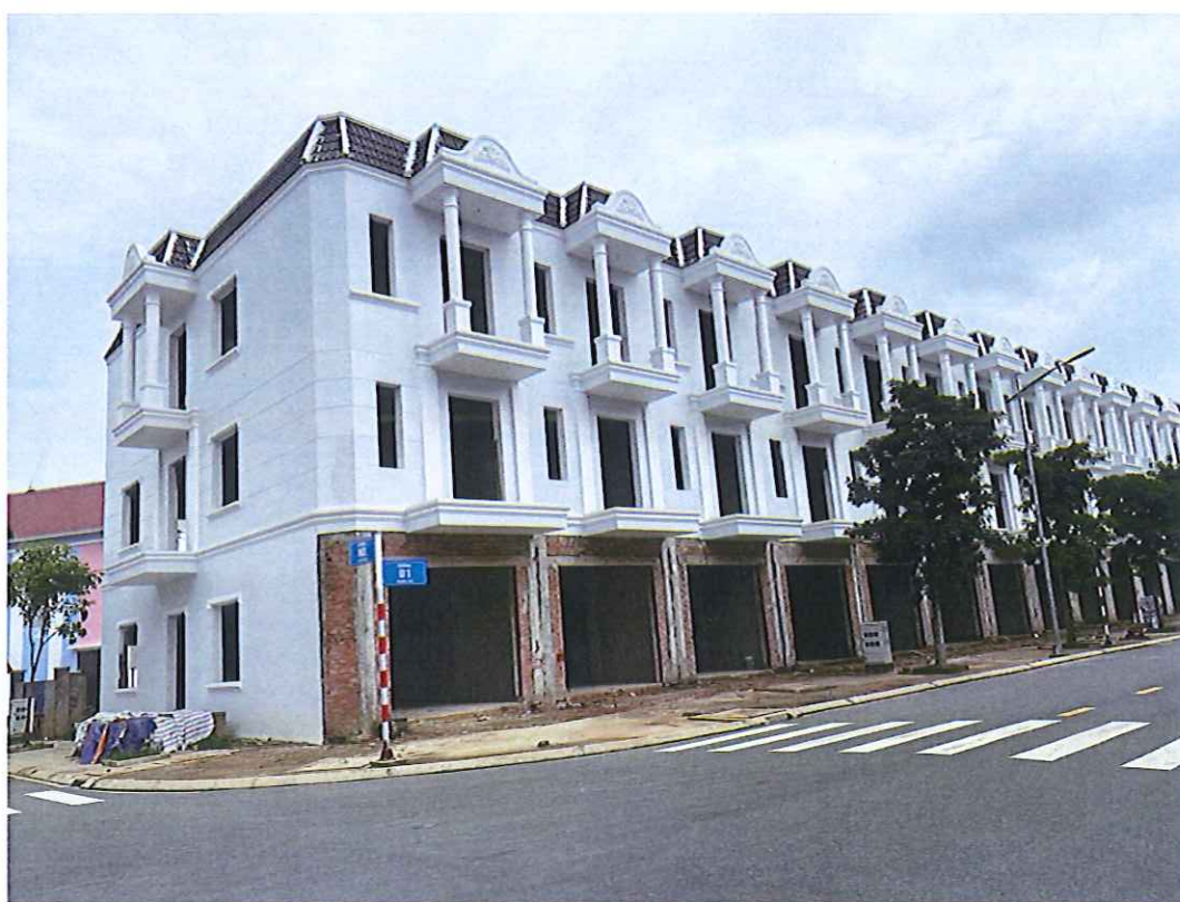
Hình 1-4: Các khối nhà đã thi công của dự án
