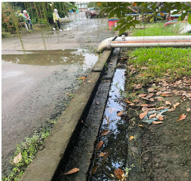
Hình 1.5. Mương thu gom nước mưa hiện hữu
