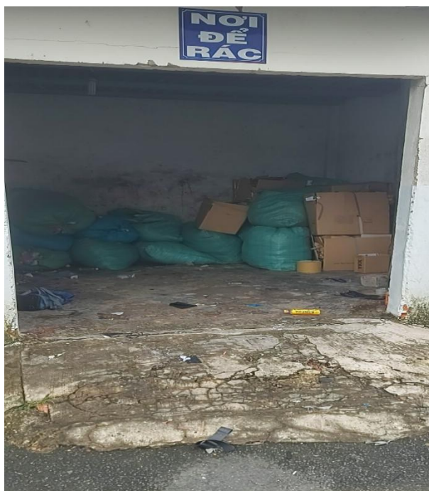
Hình 3. 13. Kho rác thải công nghiệp.
