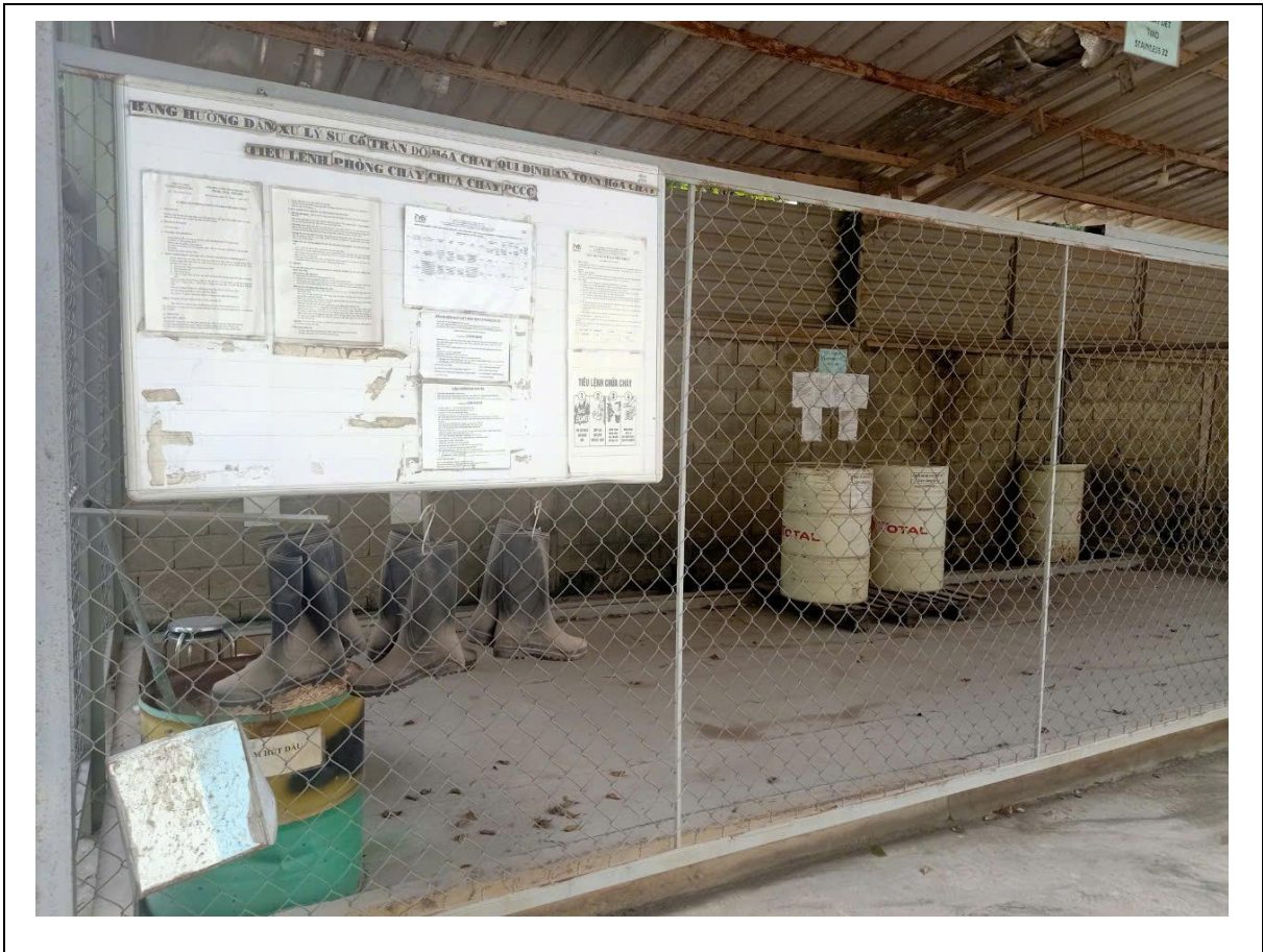
Hình 3. 16. Hình ảnh kho lưu chứa dầu của Công ty
