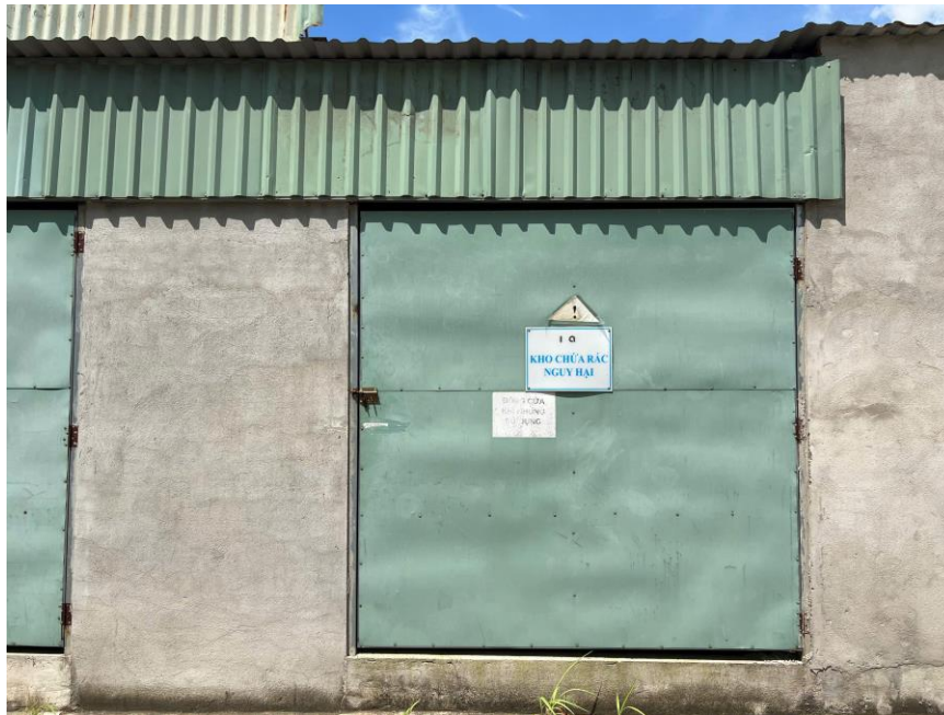
Hình 3. 13. Hình ảnh khu vực chứa chất thải nguy hại của công ty
