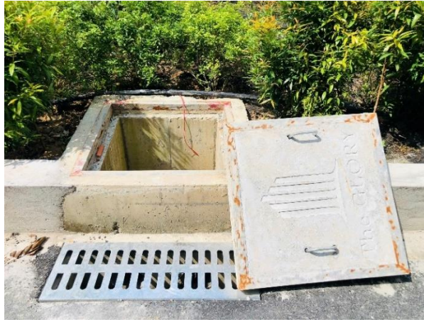
Hố ga thoát nước mưa khu vực dự án
