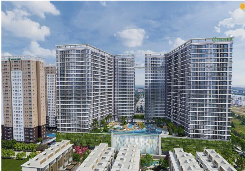
Hình 1. 5: Chung cư H9BC hoàn thiện
