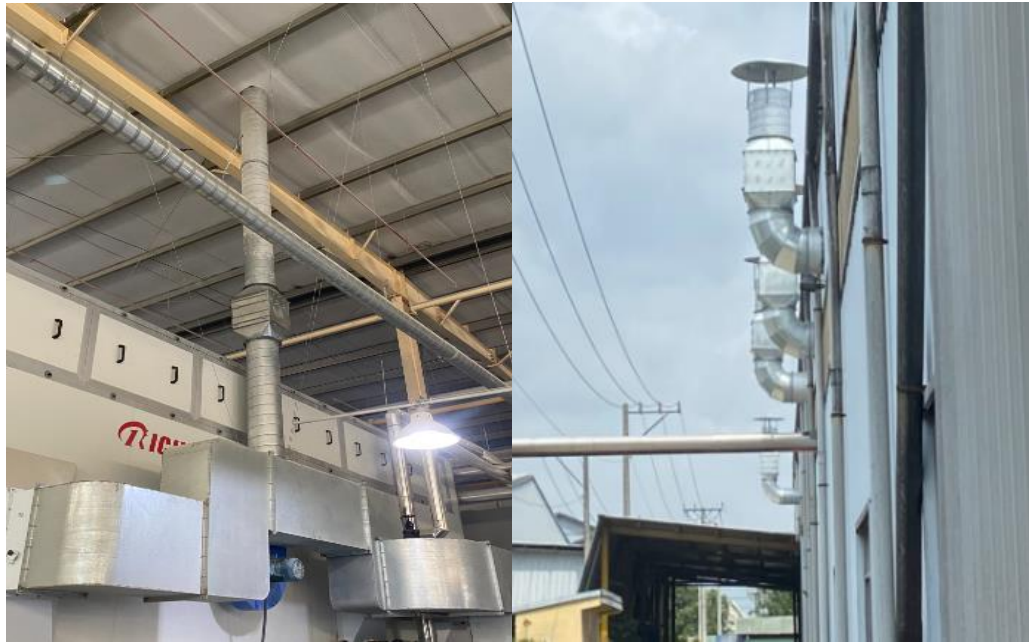
Hình 27. Hộp than hoạt tính loại 3 của hệ thống sơn khép kín
