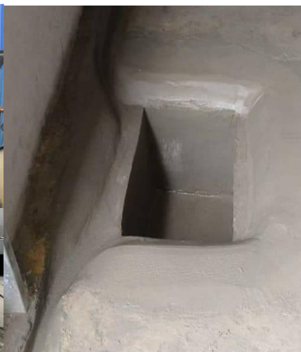
Hình 35. Hồ thu gom hóa chất chảy tràn
