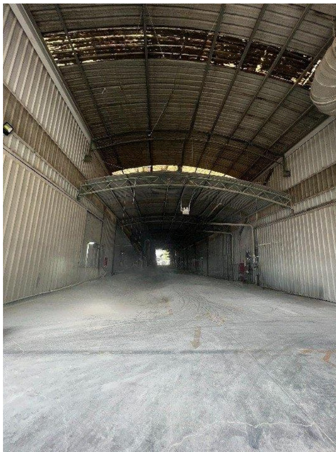
Hình 2. Khu vực mái che nhà xưởng
