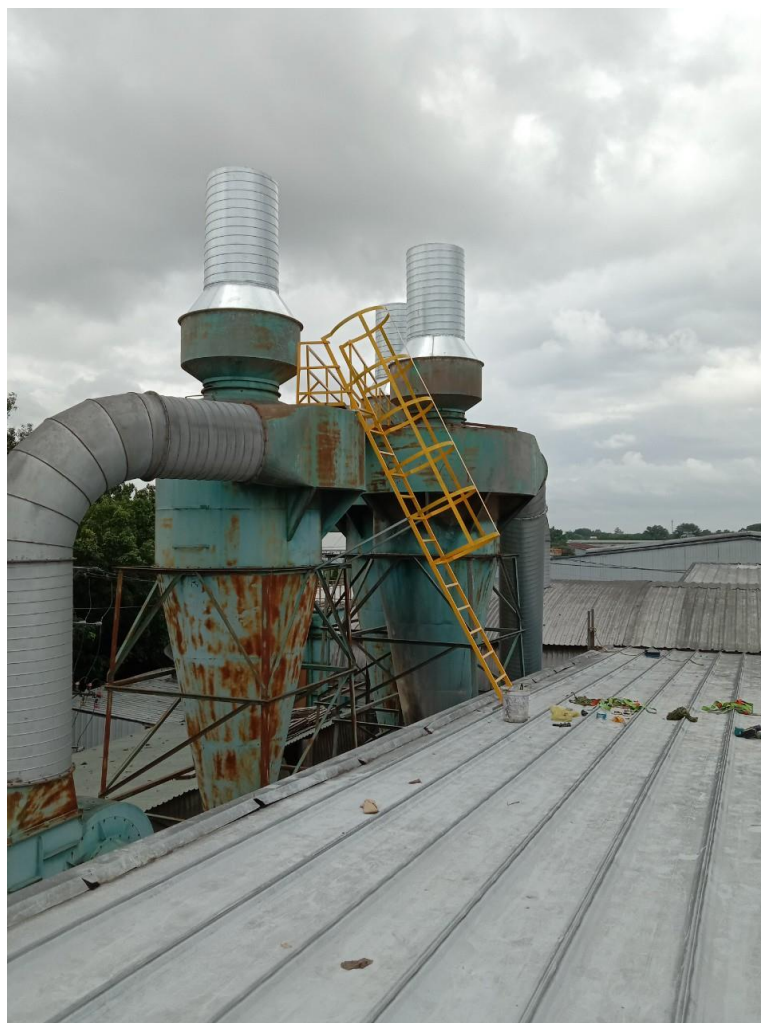
Hình 13. Hệ thống cyclone
