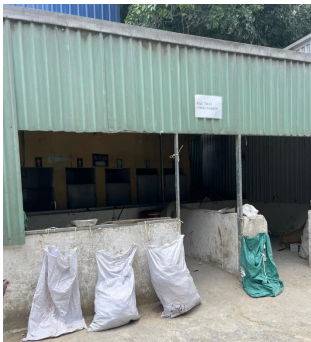
Hình 33. Nhà chứa chất thải rắn công nghiệp
