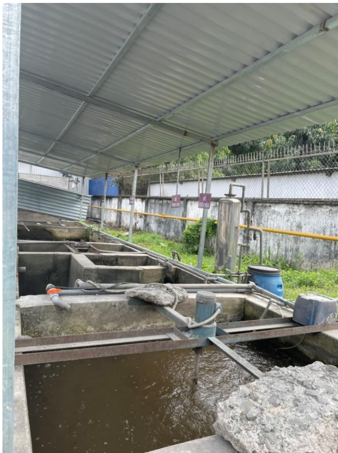
Hình 10. Hệ thống xử lý nước thải tập trung công suất 15 m 3 /ngày đêm
