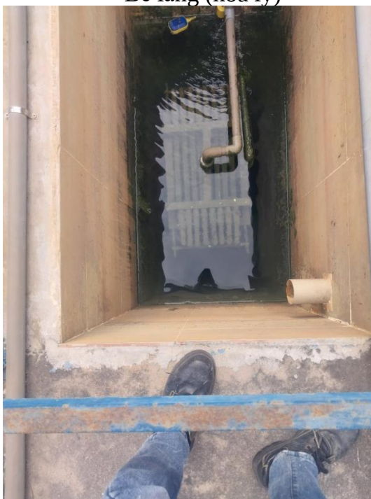
Bể lọc MBR
