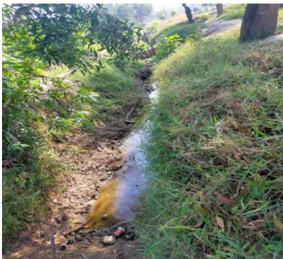
Suối cạn bên trong dự án
