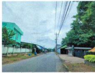
TUYẾN ĐƯỜNG NHỰA AN PHÚ 17 HIỆN HỮU
