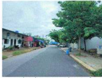
TUYẾN ĐƯỜNG NHỰA AN PHÚ 17 HIỆN HỮU
